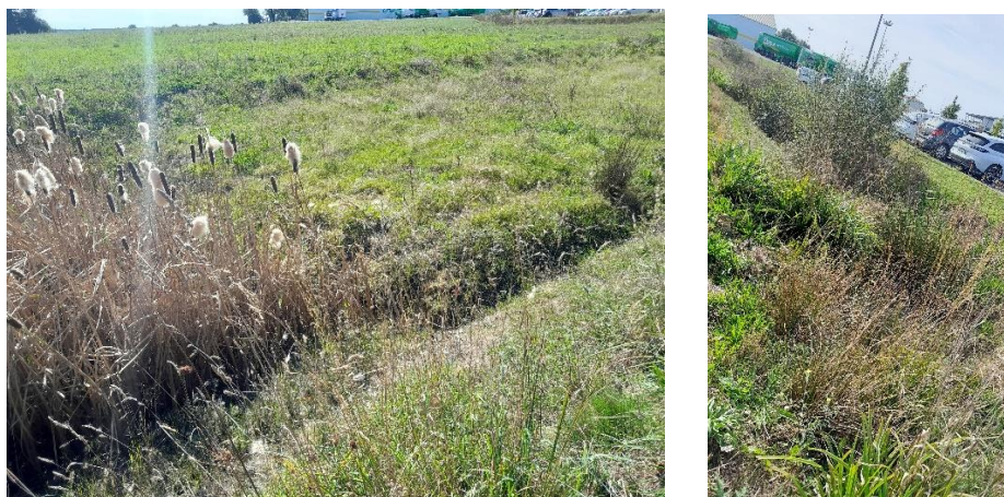
Fig. 10. Photographies du bassin de gestion d'eau pluviale et fossé
